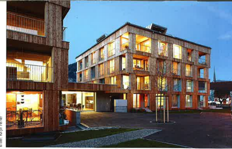
Blick von Süden auf den Zwischentrakt mit zentralem Eingangsbereich
